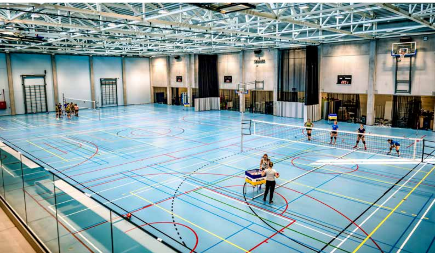
De bestaande sporthal kreeg nieuwe elektriciteit, verwarming en kleedkamers.
